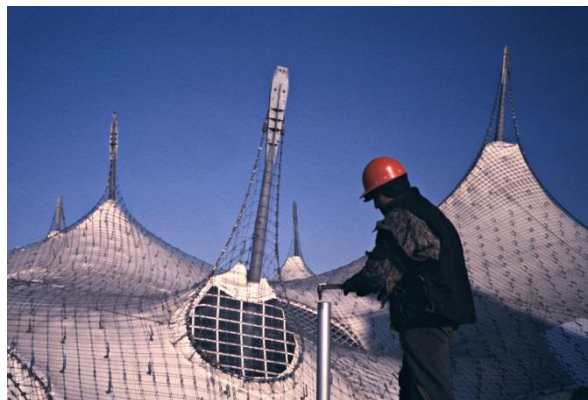
Jean-Louis Frund, Construction du pavillon de l'Allemagne , Montréal, janvier 1967, MP-1994.1.2.997 © Musée McCord
